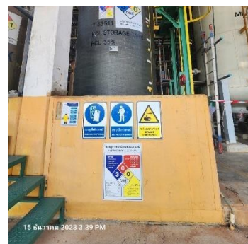
ภาพที่ 2-32 คันกั้นล้อมรอบถังเก็บสารเคมีป้องกันการรั่วไหล
