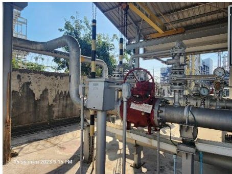
ภาพที่ 2-38 อุปกรณ์ความปลอดภัยของระบบท่อส่งก๊าซ
