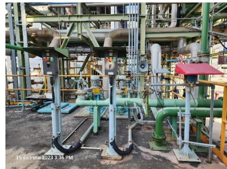
ภาพที่ 2-12 เครื่องมือตรวจวัดคุณภาพน้ำอัตโนมัติ บริเวณบ่อพักน้ำทิ้ง (Holding Pond)
