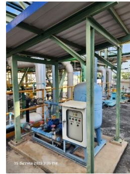
ภาพที่ 2-9 การติดตั้งอุปกรณ์รดน้ำต้นไม้และนำน้ำทิ้งกลับมาใช้ประโยชน์ในการรดน้ำต้นไม้ในพื้นที่โครงการ
