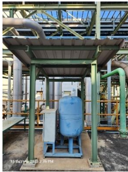
ภาพที่ 2-9 การติดตั้งอุปกรณ์รดน้ำต้นไม้และนำน้ำทิ้งกลับมาใช้ประโยชน์ในการรดน้ำต้นไม้ในพื้นที่โครงการ
