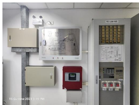
ภาพที่ 2-26 อุปกรณ์เตือนภัยแบบอัตโนมัติ
