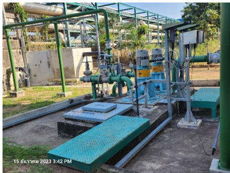
ภาพที่ 2-11 บ่อตรวจสอบคุณภาพน้ำเสีย (Inspection Manhole)
